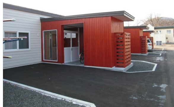
写真3 カラマツ羽目板を利用した玄関周り
