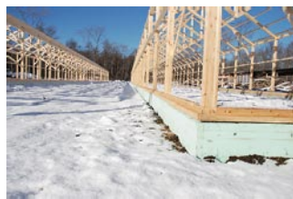
写真3 木造無加温温室の基礎
