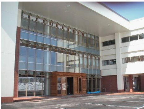
写真7 旭川市障害者福祉施設
