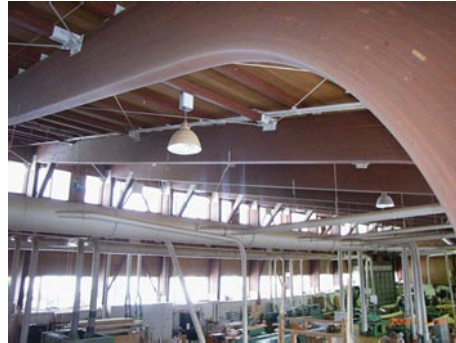
写真 3 試験棟の大断面集成材
