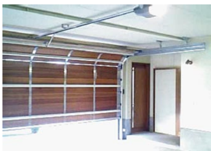
写真9 木製オーバードアの格納の様子(開け始め)
