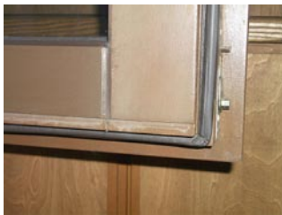
写真16 角に切れ込みを入れた気密材
