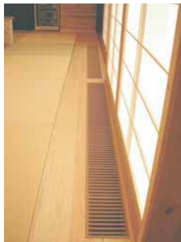
写真2 窓からの冷気流を抑えるガラリ
