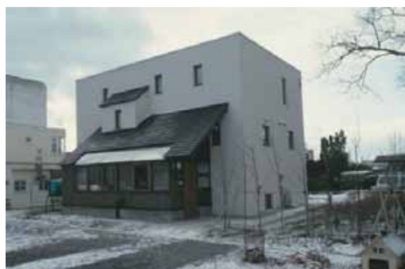
写真8 北面の風除室
