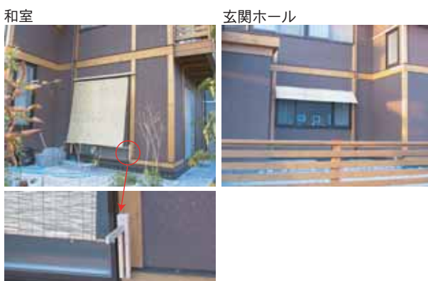
写真6 和室と玄関ホール
