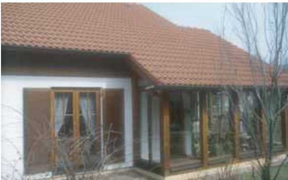
写真7 壁のガラス張り
