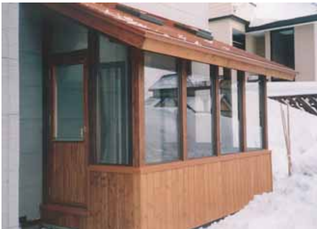
写真1 木製サンルームの外観
