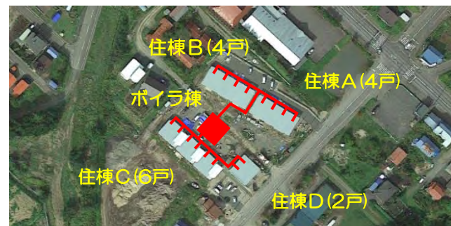
津別町西町団地（計16戸）木質バイオマスによる熱供給施設
