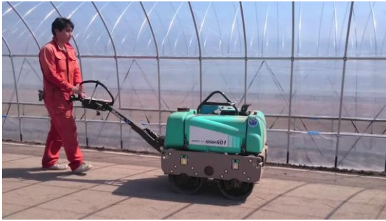
ローラーによる鎮圧作業
