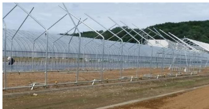
写真 3-1-2 アーチ柱の差し込み
