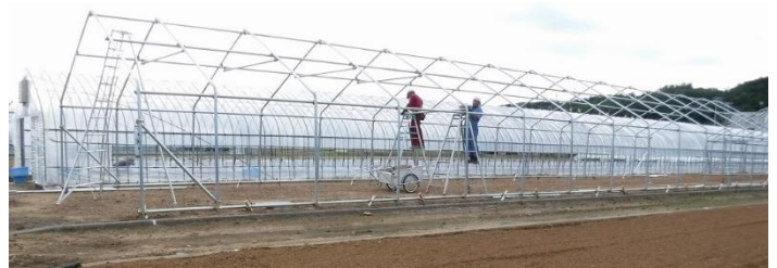
写真 3-3-2 タイバー横管の固定
