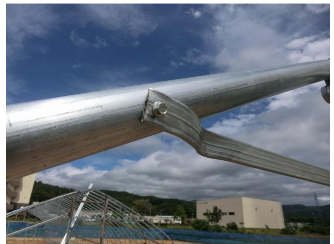
写真 3-6-3 妻面上部のフィルム留材末端
