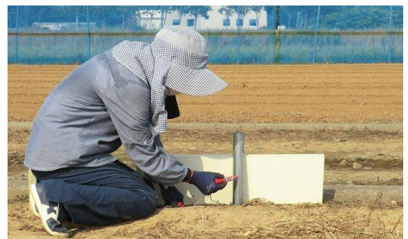
写真 2-2-3 レーザー位置のマーク
