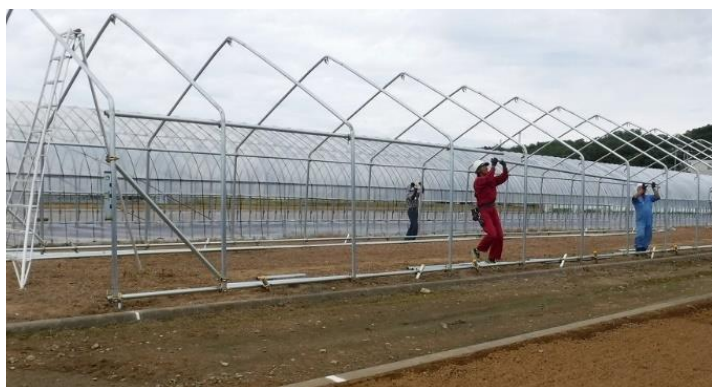
写真 3-2-2 軒桁の固定
