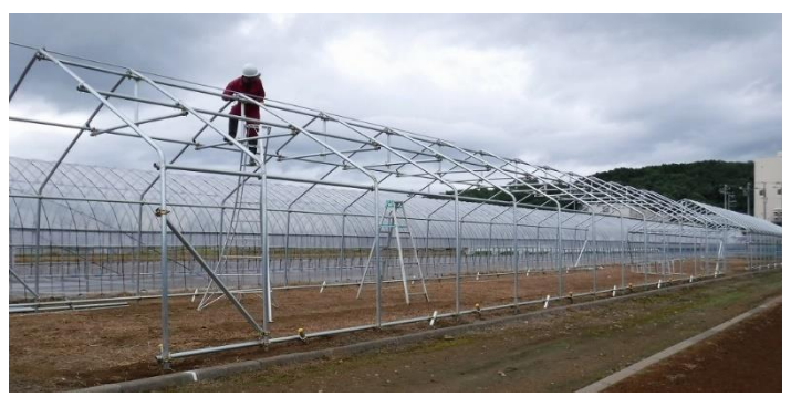
写真 3-3-3 タイバー縦管の固定
