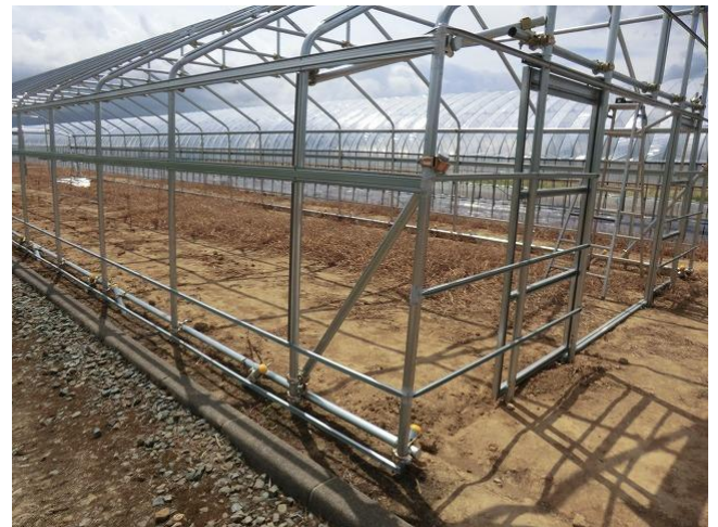
写真 3-6-2 妻面と側面のフィルム留材
