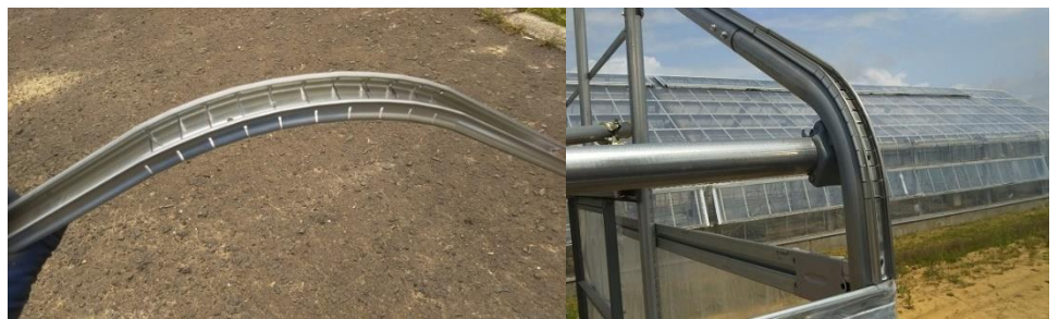
写真 3-6-5 単管湾曲に合わせたフィルム留材の加工
