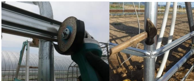
写真 3-6-6 フィルム留材の末端処理
