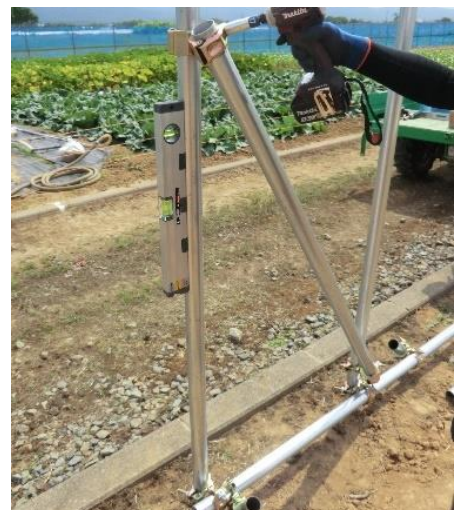
写真 3-1-3 天井繋ぎ管で接続
