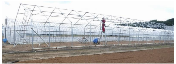
写真 3-3-4 タイバーのジャッキアップ
