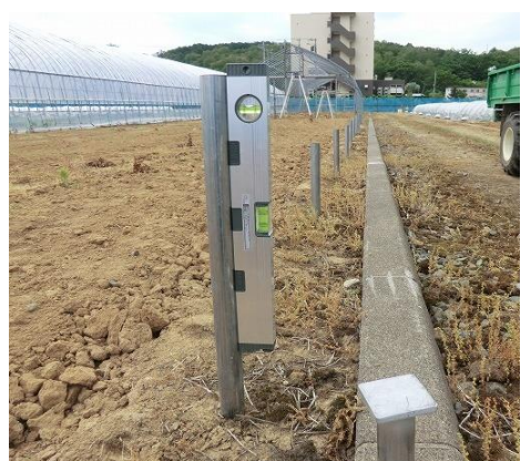
写真 2-1-4 ダンポールと基礎杭の位置（左）、電動ハンマーでの打ち込み(中)、垂直の確認（右）
