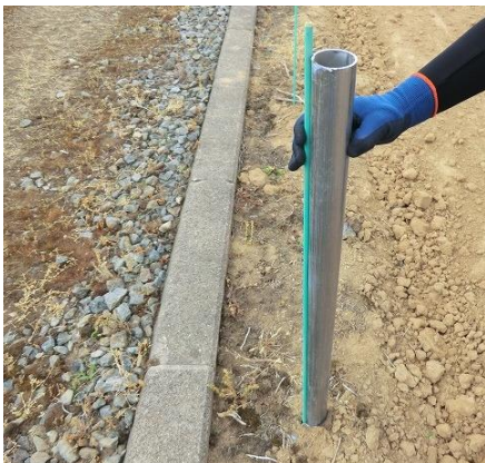
写真 2-1-4 ダンポールと基礎杭の位置（左）、電動ハンマーでの打ち込み(中)、垂直の確認（右）
