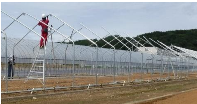
写真 3-1-3 天井繋ぎ管で接続
