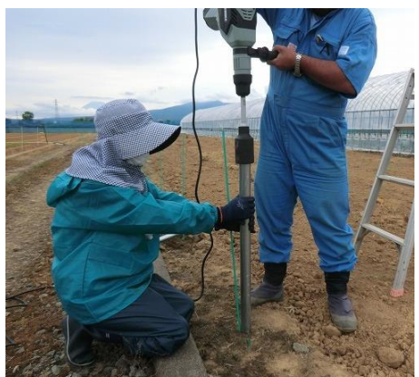
写真 2-1-4 ダンポールと基礎杭の位置（左）、電動ハンマーでの打ち込み(中)、垂直の確認（右）
