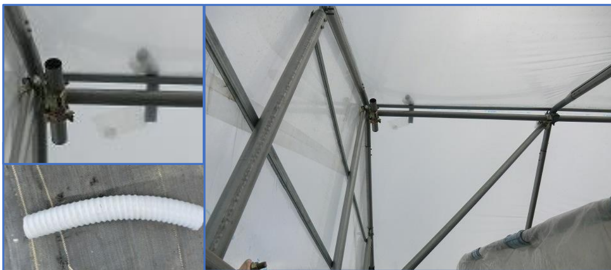
写真 7-13 設置したダクトホース (左下) 棟部の PO フィルムの間に設置 (左上、右)
