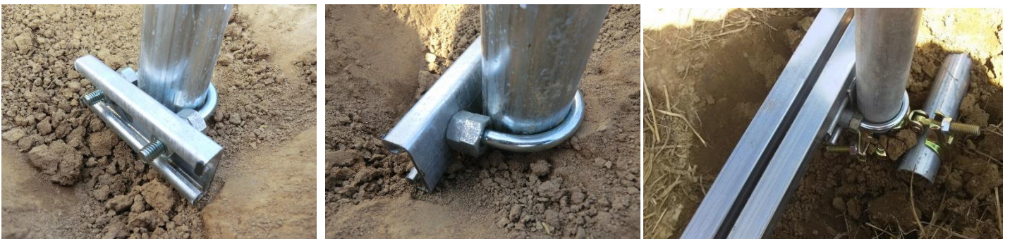
写真 7-8 下レール受け金具の自作(上、中、下)
