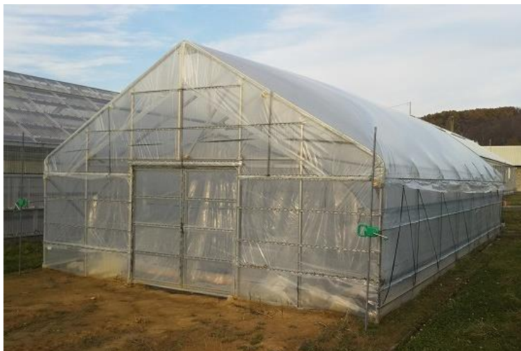
写真 7-12 単管空気膜二重ハウス
