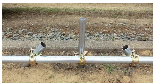
写真 2-4-3 根太の固定
