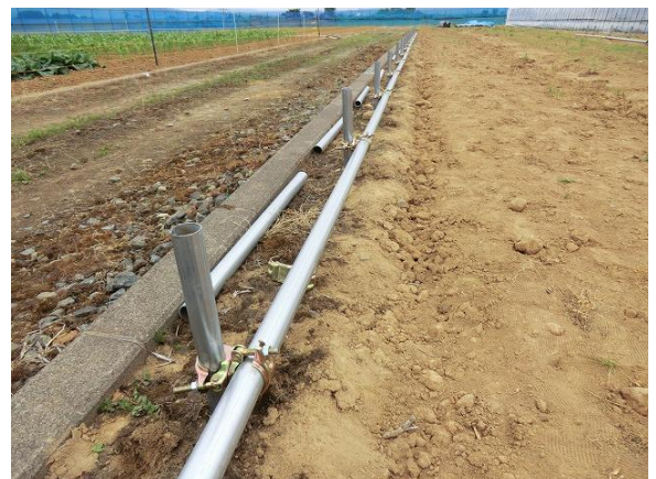
写真 2-3-3 根太の固定
