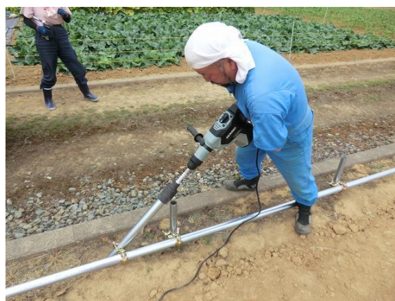
写真 2-4-2 ハンマーでの打ち込み
