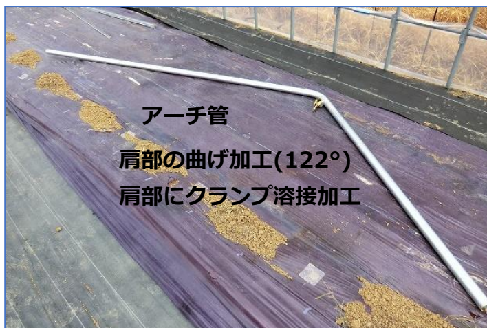
写真 5-3-1 加工依頼したアーチ管
