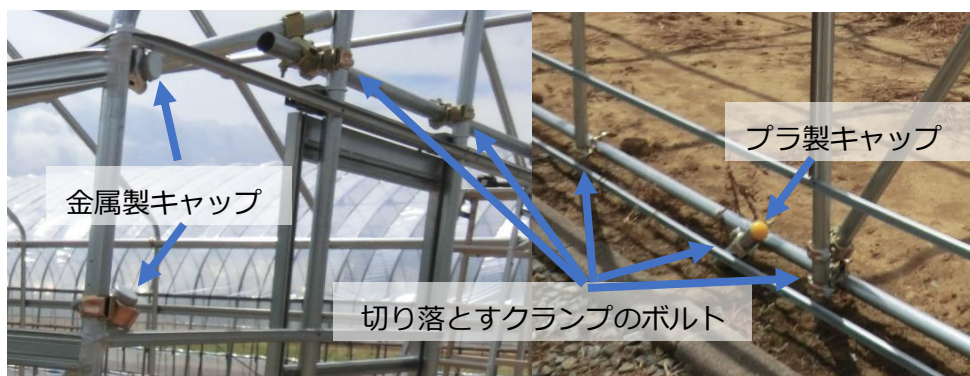
写真 3-6-7 単管キャップとボルト先端処理
