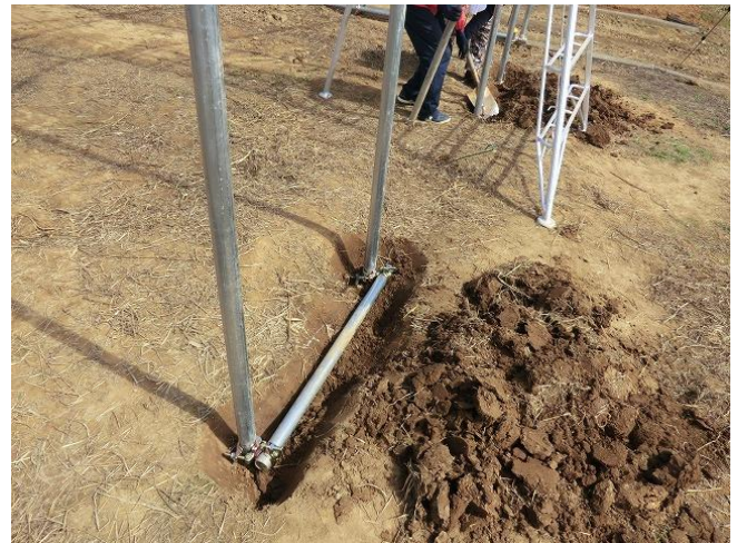
写真 3-4-2 妻面基礎杭の根がらみ
