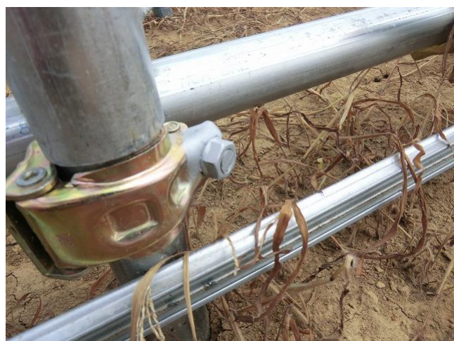
写真 3-6-8 ボルト先端処理
