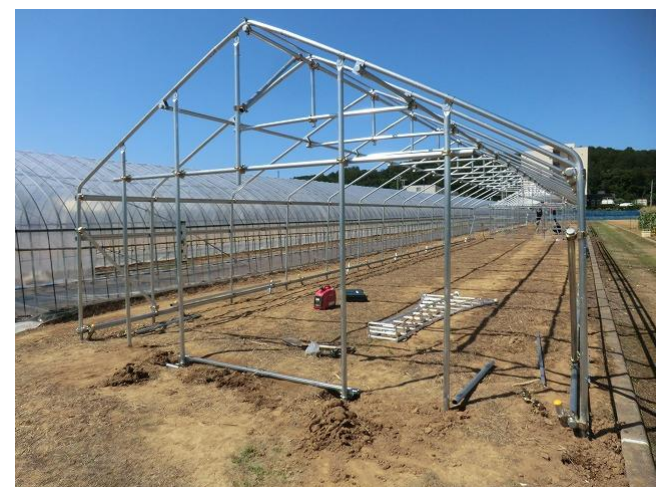
写真 3-4-3 妻面梁を 5 本の柱と固定
