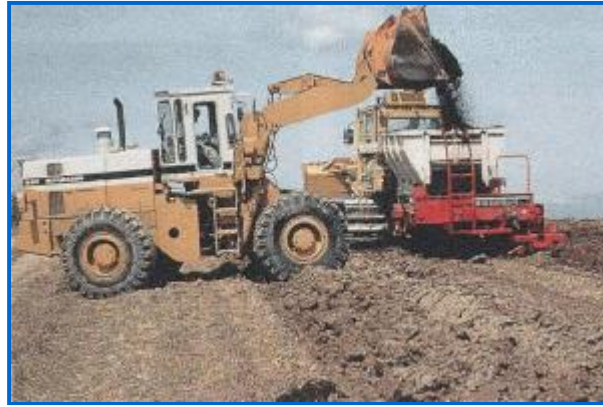
有材心土改良耕の施工時の様子
