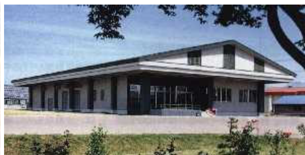
植物遺伝資源種子貯蔵管理施設の全景 (1998年3月完成)
