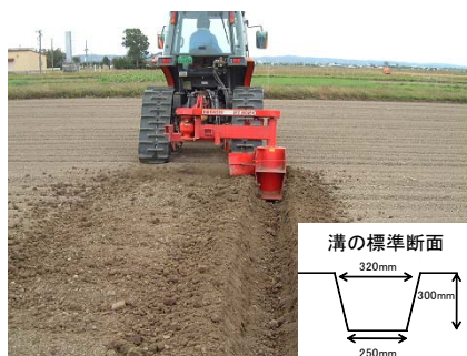
図一2 圃場内明渠の施工状況 (秋播小麦播種直後)
