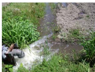
図一3 用水からの給水状況（左：管水路、右：開水路）
