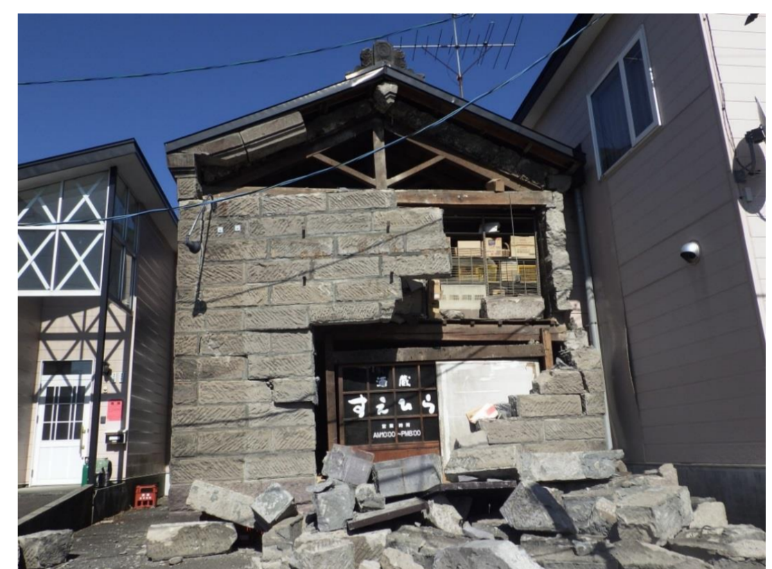
写真2 組積造被害
