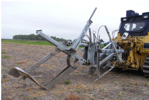
カッティングドレーン カッティングドレーン施工風景
