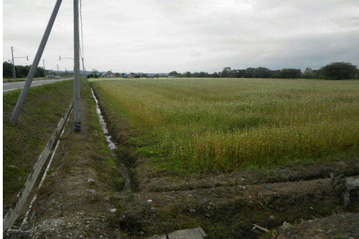
額縁明渠施工前
