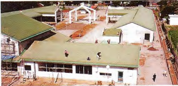
◀大豆優良種子増殖 研修プロジェクト庁舎(建設中)
