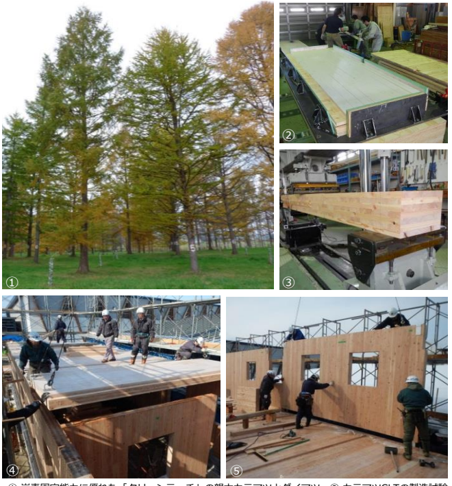
① 炭素固定能力に優れた「クリーンラーチ」の親木カラマツとグイマツ ② カラマツCLTの製造試験 ③ 道産CLT材料性能試験 ④ ⑤ 道産カラマツCLTによる木造建設
