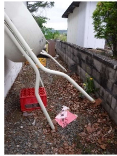
写真 2-1 灯油タンクと集合煙突の被害
