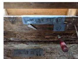
(b) C 棟 浴室土台
