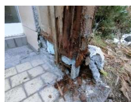
(a) B 棟 風除室
