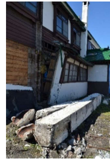
写真 2-1 灯油タンクと集合煙突の被害
