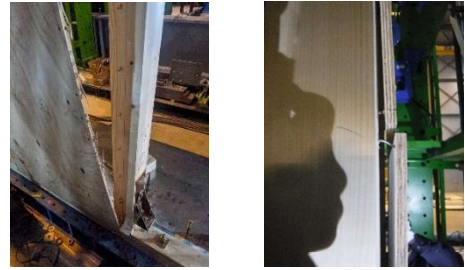
(a) 頭抜け (No2) (b) 引き抜け破壊 (No14) 写真 3-1 釘の破壊形状
