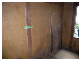
(a) A 棟変状調査
