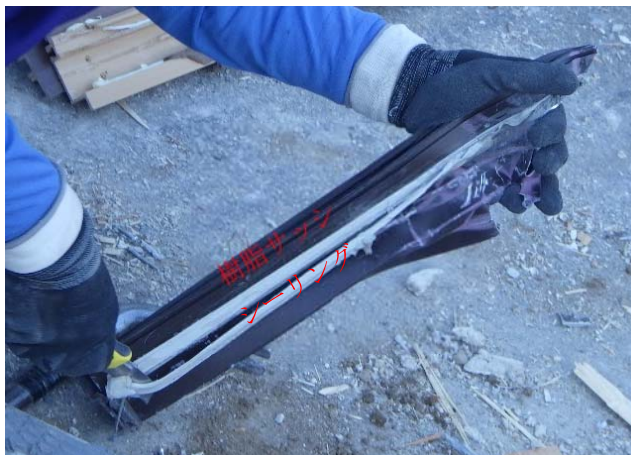
写真 2-20 重機で解体した窓の外枠からカッターでシーリングをそぎ落としているところ (G)
