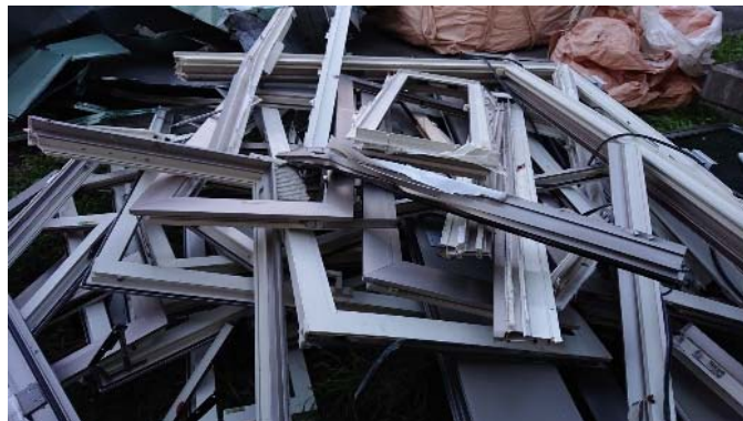
写真 2-3 ガラスを取り外した樹脂サッシ (D)
