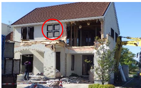
写真 2-7 高所の窓やはめ殺しの窓を設置したまま重機で解体 (左：B、右：E)
