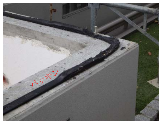
写真 2-23 基礎天端のパッキン (H)
