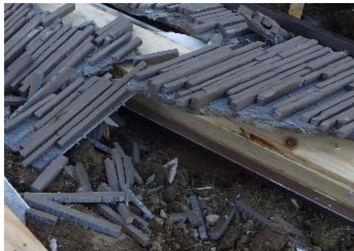
写真 2-31 サイディングが重機による解体の衝撃で碎け、土等と混ざった様子 (G)
