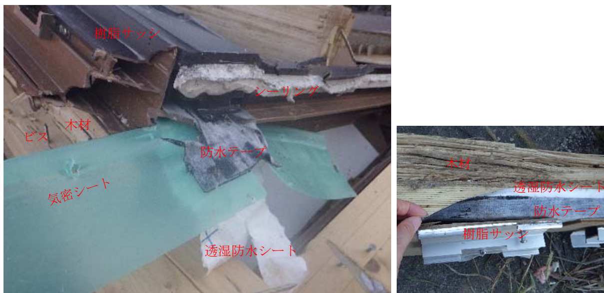
写真 2-17 重機で解体後に様々な解体材が付着しているところ (G)
