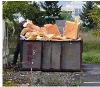
写真 2-12 解体されたボード状フェノール断熱材 (B)
