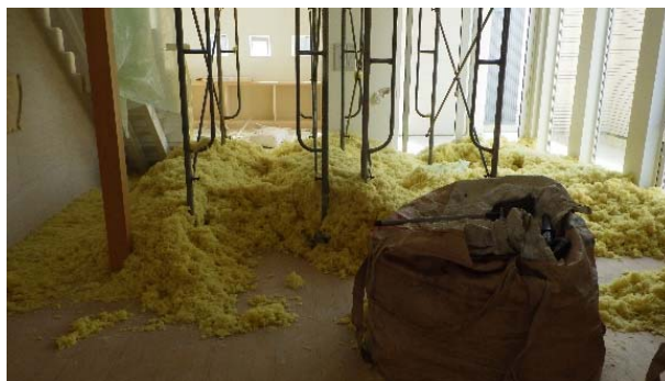
写真 2-9 ブローイング断熱材の解体の様子（床に落としたところ）(E)
