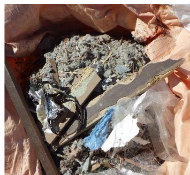
写真 2-2 複数の種類の解体材が 1 つのトン袋に入れられている状態 (G)
