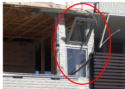
写真 2-7 高所の窓やはめ殺しの窓を設置したまま重機で解体 (左：B、右：E)
