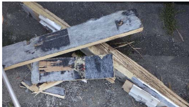
写真 2-18 防水テープが付着した木材が他の木材と分別されている様子 (G)
