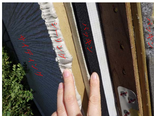
写真 2-22 壁パネルのパッキン等 (C)
