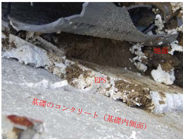
写真 2-13 基礎断熱を電動ピックで途中まで剥がしたところ (H)
