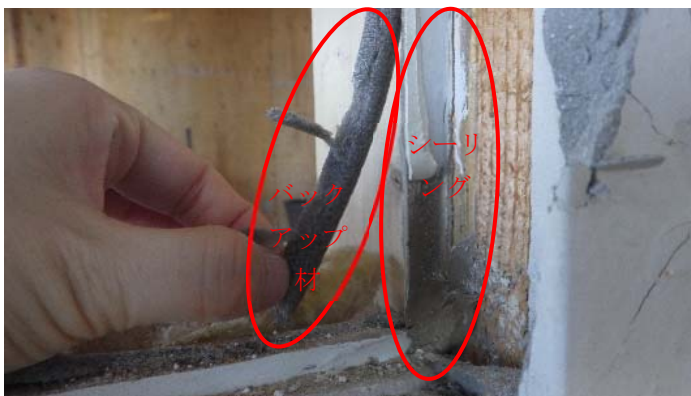
写真 2-6 木製サッシの解体状況 (A)
