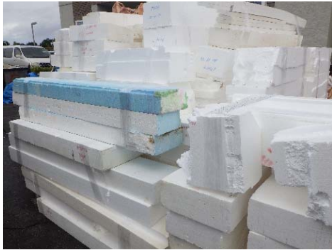
写真 2-11 解体されたビーズポリスチレンフォーム断熱材 (C)
