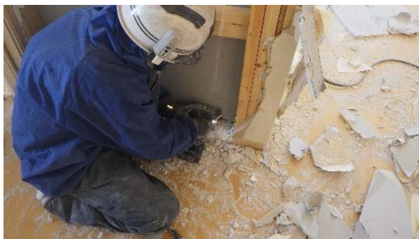
写真 2-28 躯体の金物を取り外しているところ (E)
