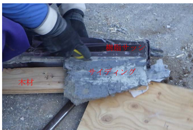
写真 2-21 重機で解体後に窓の外枠、サイディング、木材をカッターやバールで分別しているところ (G)
