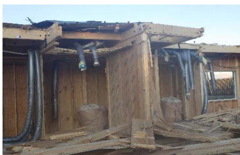
写真 2-25 換気用の断熱付きのフレキシブルダクト等を重機で解体しているところ (E)
