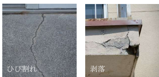
図 1-1 構造物に発生する変状の代表例
