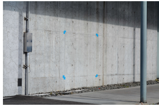
図 4-1 ひび割れ検出の検討用外壁
