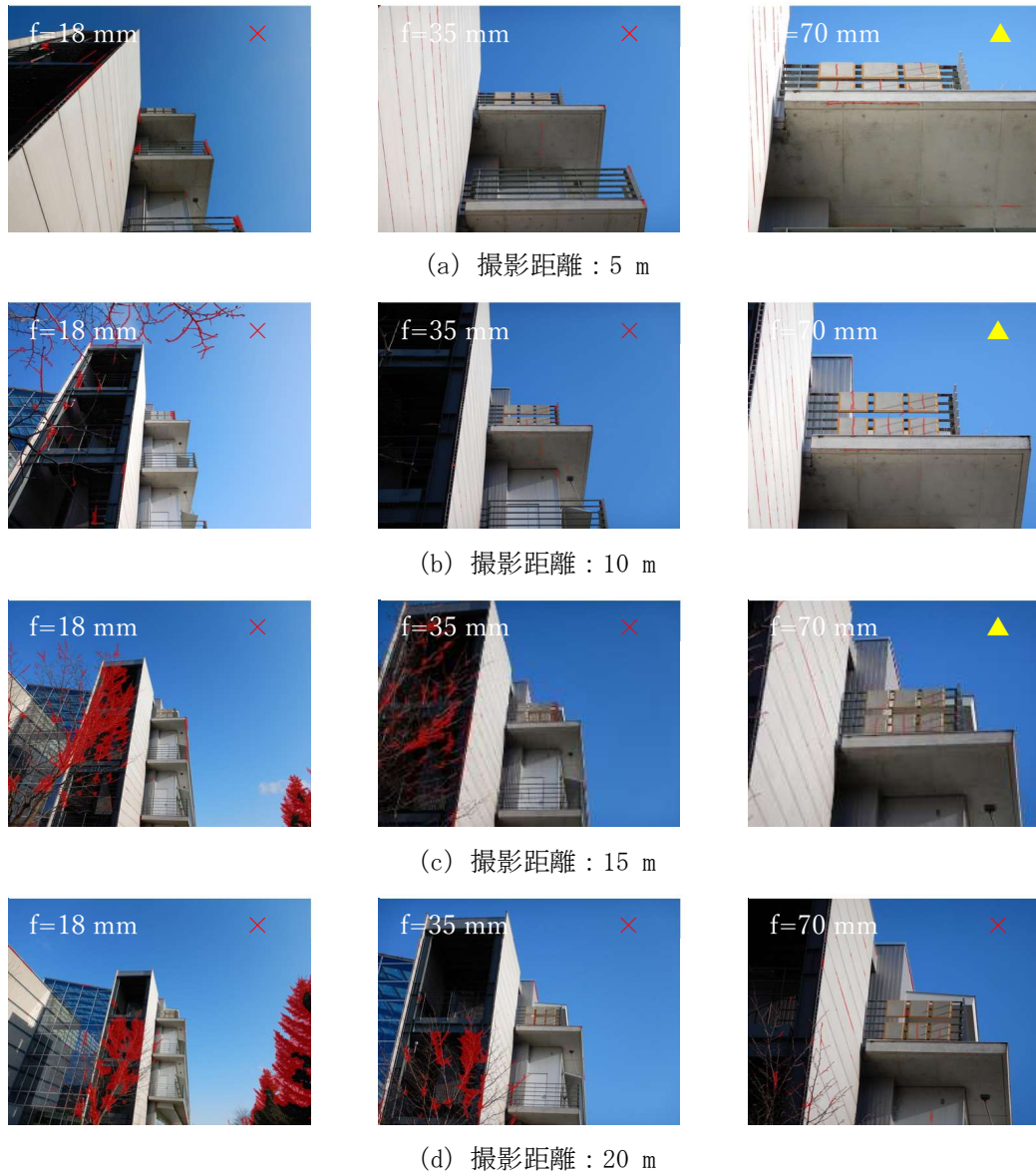
図 3-9 ひび割れ検出結果 (試験体設置位置 4 階, コンパクトデジタルカメラ使用)
