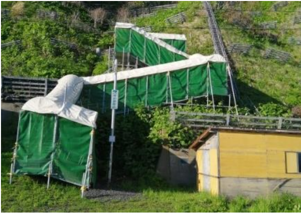
写真7 整備された避難階段
