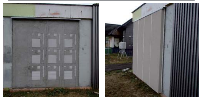
図2 模擬浮き配置状況および外断熱施工後外観
