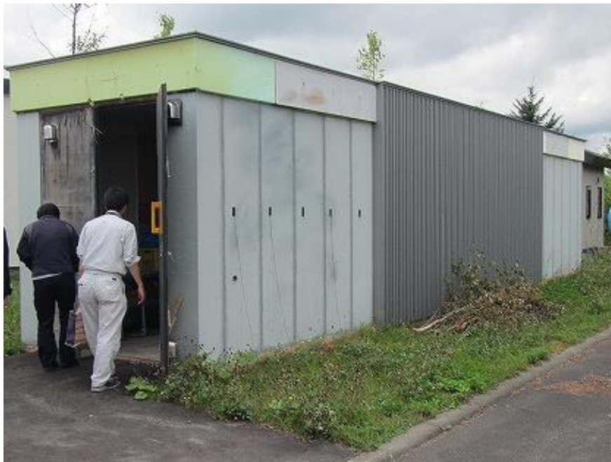
写真 3-2 施工前の RC 実験棟北面の状況
