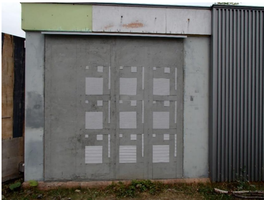
写真 3-6 模擬浮きの貼付状況 (外断熱外壁試験体)
