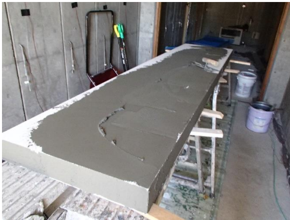
(c) EPS ボードへの樹脂モルタルの塗布
