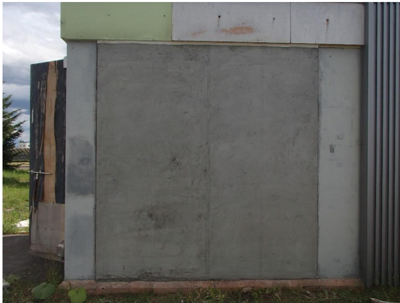
写真 3-5 外断熱パネル施工前の状況
