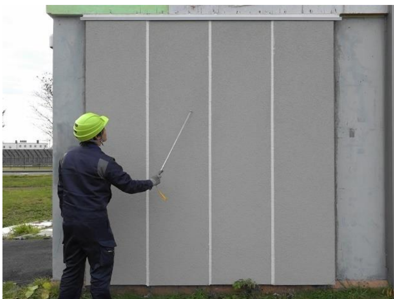
写真 3-12 外断熱外壁試験体の打診棒による浮き検出
