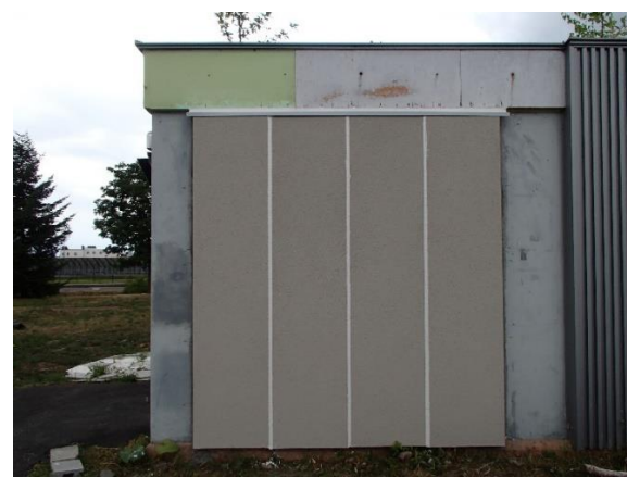
(d) 外断熱パネル施工後の状況
