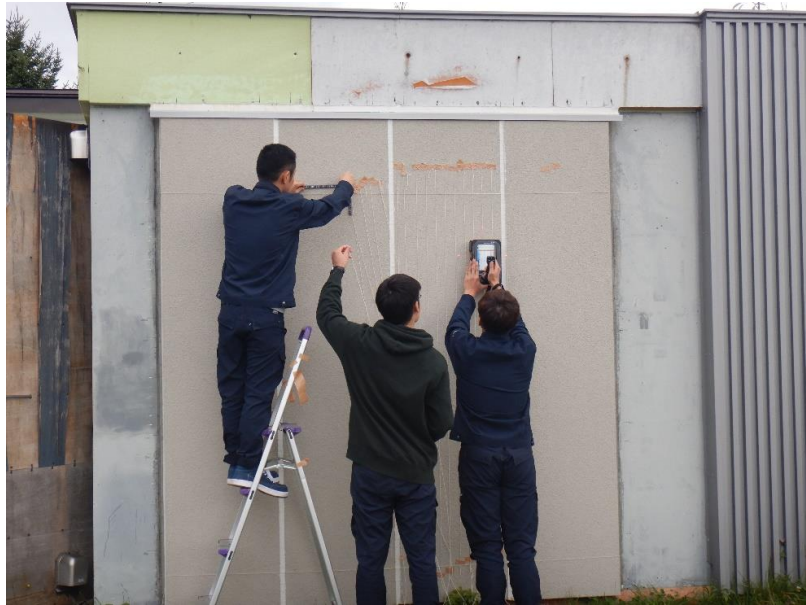
写真 3-13 電磁波レーダーによる外断熱外壁の探査の様子
