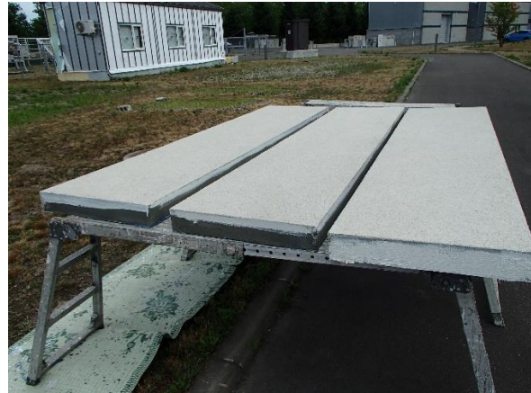
(f) フィニッシュコートの施工
