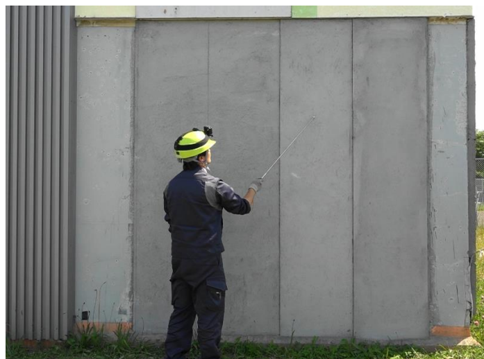
写真 3-10 モルタル外壁試験体の打診棒による浮き検出
