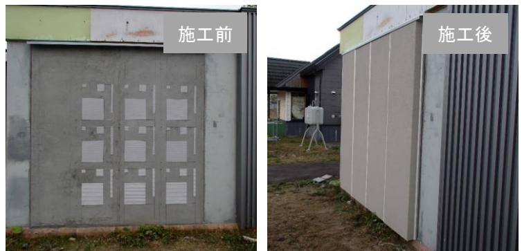
写真1 外壁試験体の外断熱施工前および施工後の状況
