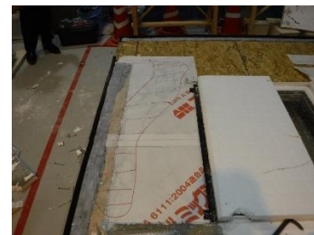
(a) 試験体の外気側から見て左
