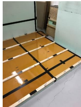
写真 6 通気層内観 (通気層面平滑)
