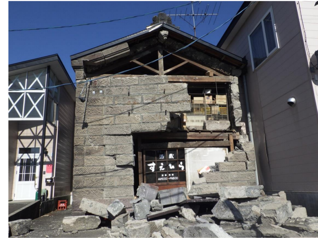
写真2 混構造被害
