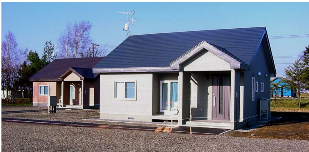
図 4-2-1 実証住宅外観
