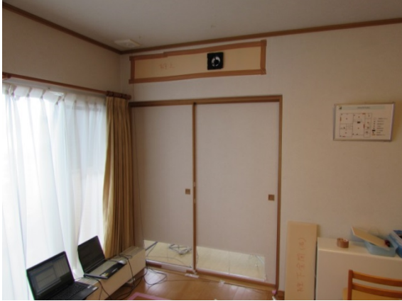
図 4-2-5 (左) 和室とLDK、(右) 洋室とLDK (キッチン) 間の上部開口にファンを設置した状態
