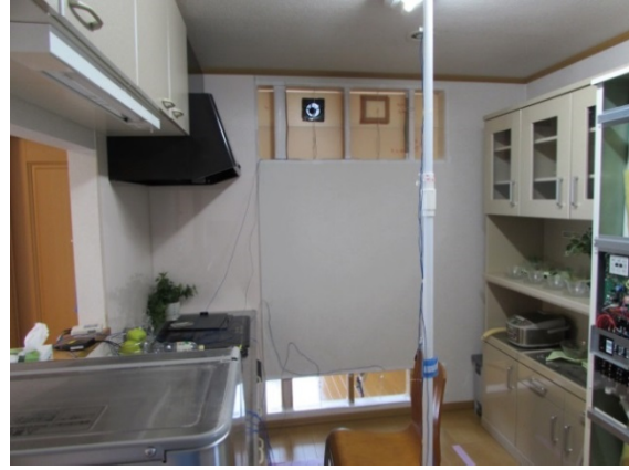
図 4-2-5 (左) 和室とLDK、(右) 洋室とLDK (キッチン) 間の上部開口にファンを設置した状態
