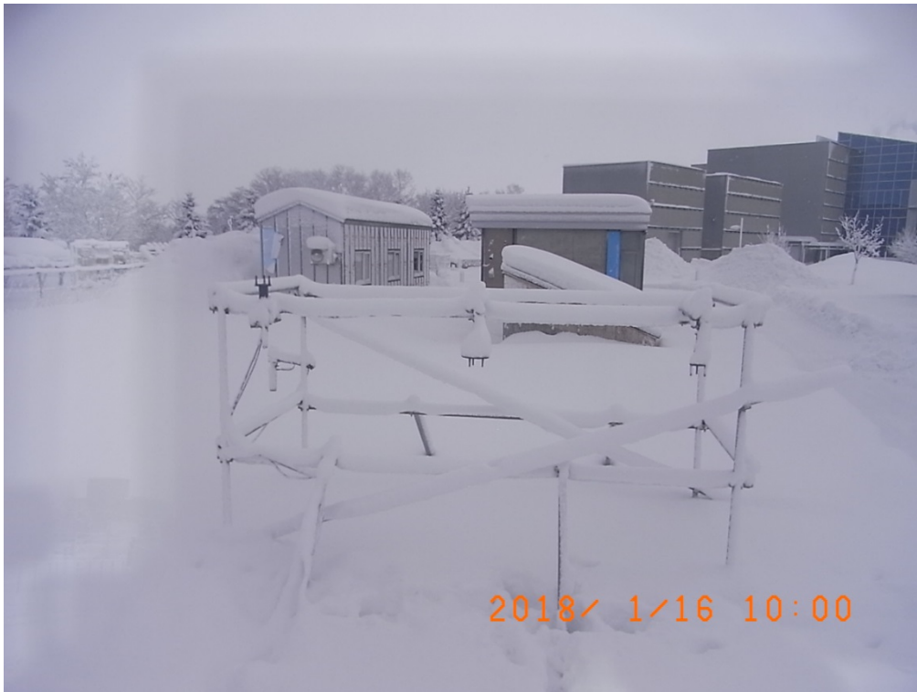
写真 5-4 2018/1/16 における風向風速計の着雪状況
