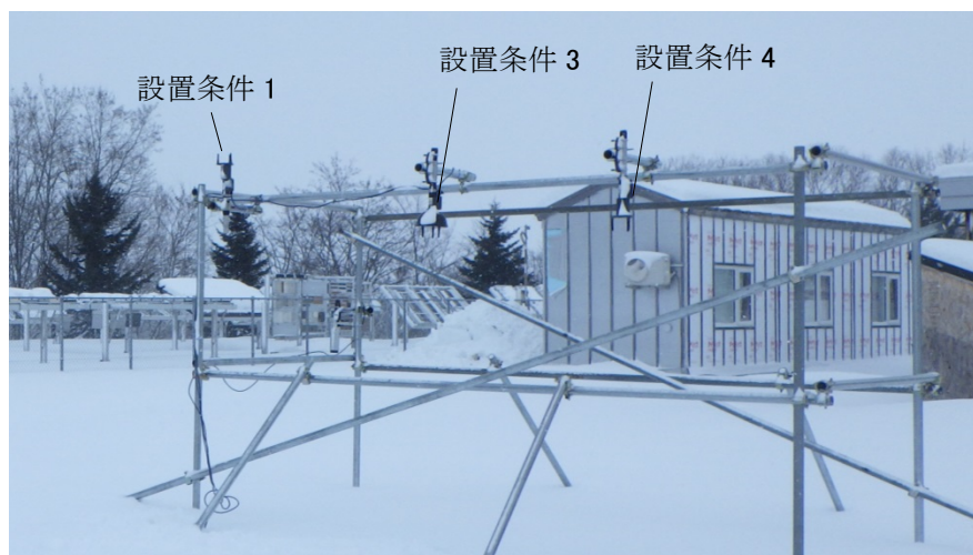
写真 5-2 屋外実験（平成 29 年度）における風向風速計の設置状況
