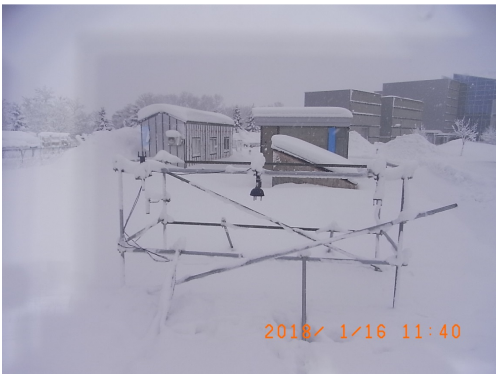
写真 5-5 2018/1/16 における防雪フードからの落雪状況
