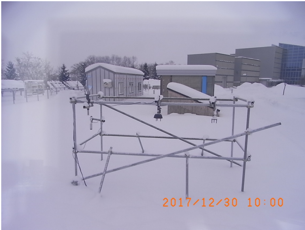
写真5 2017/12/30における風向風速計の着雪状況
