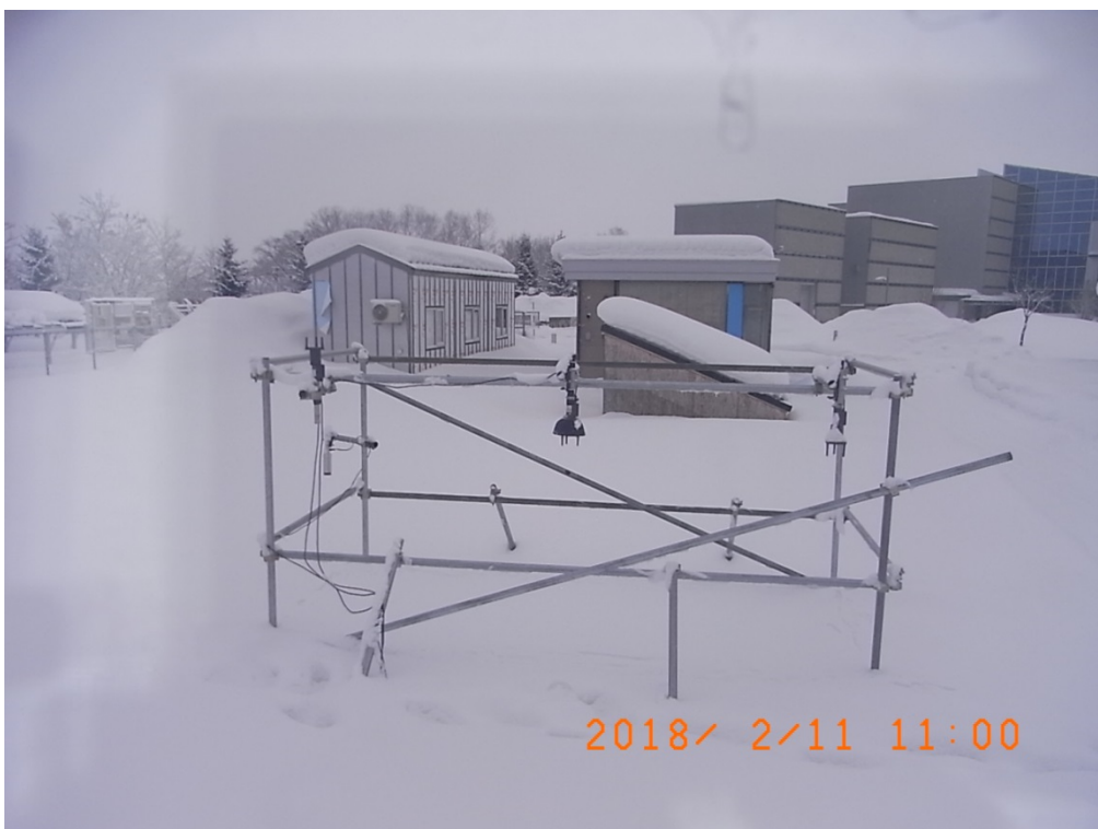
写真 12 2018/2/11 における風向風速計の着雪状況
