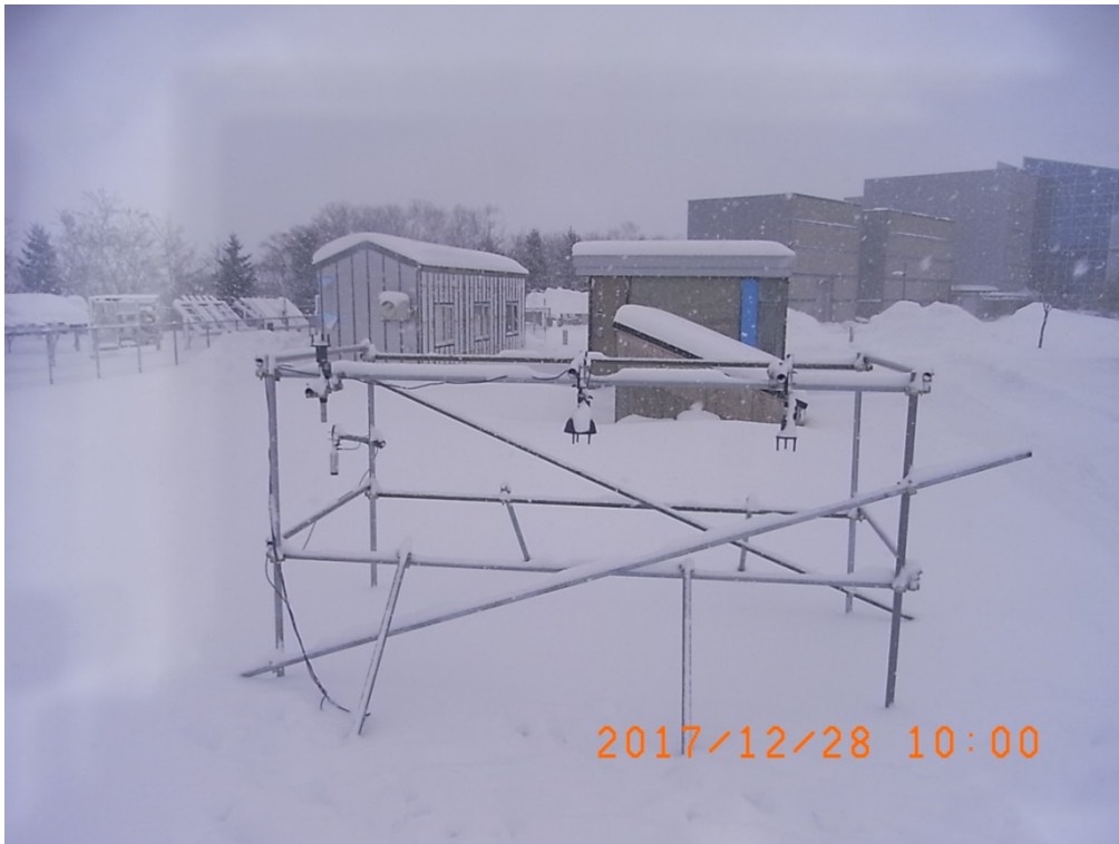
写真3 2017/12/28における風向風速計の着雪状況
