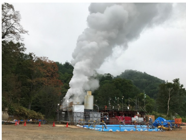
写真 1-2 地熱発電の試掘の状況
