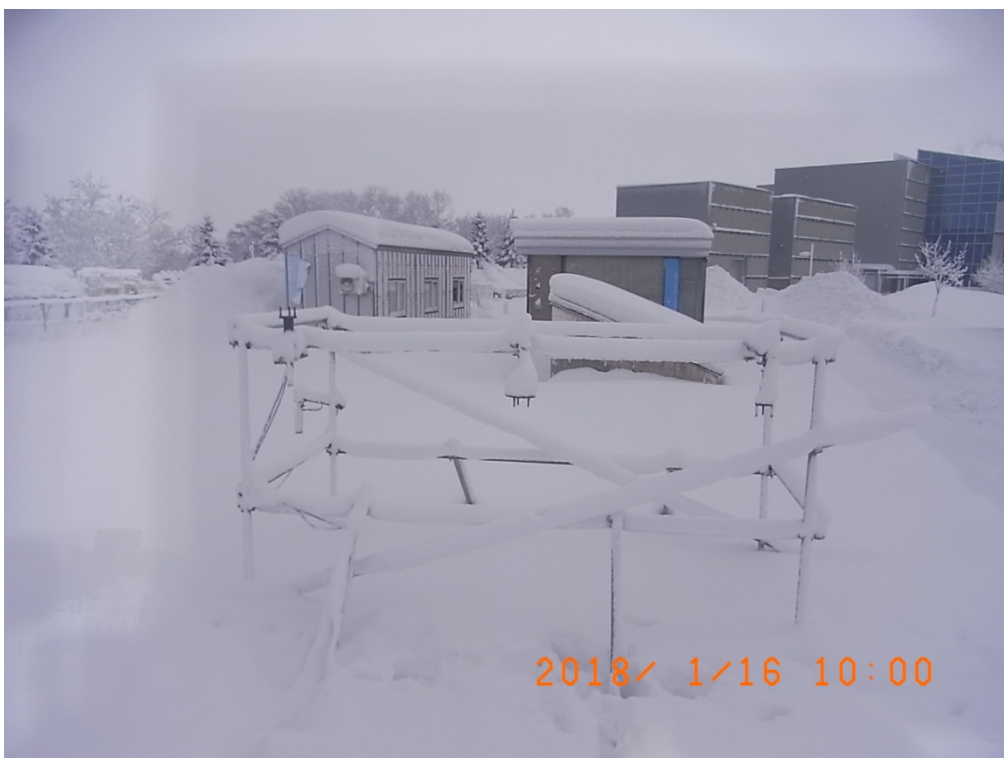
写真8 2018/1/16における風向風速計の着雪状況
