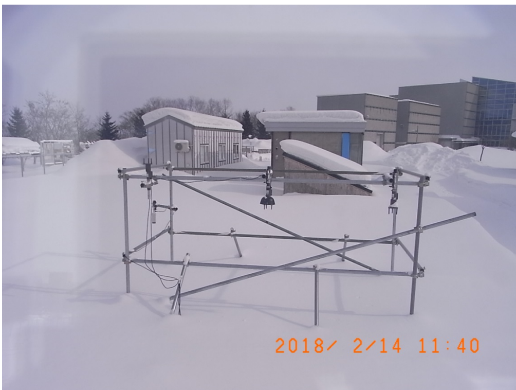
写真 14 2018/2/14 における風向風速計の着雪状況
