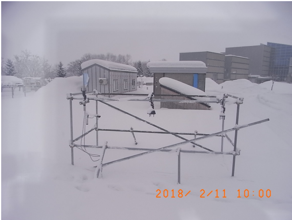
写真 11 2018/2/11 における風向風速計の着雪状況
