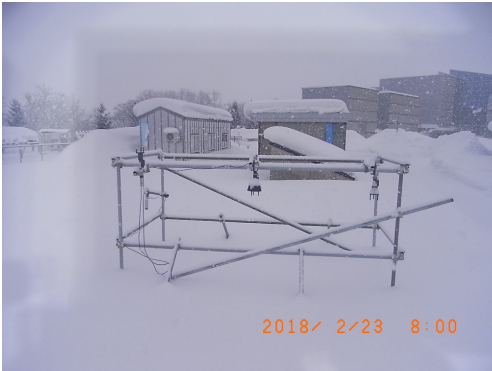
写真 17 2018/2/23 における風向風速計の着雪状況
