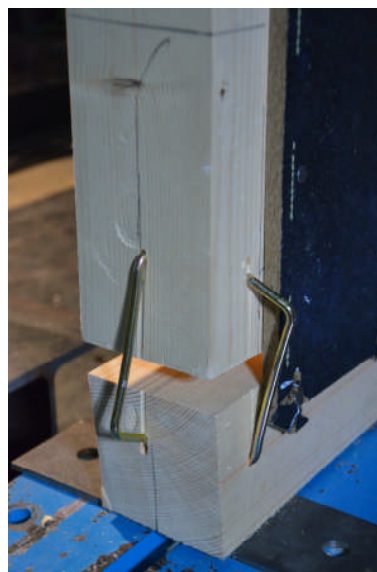
かすがいの引き抜け
