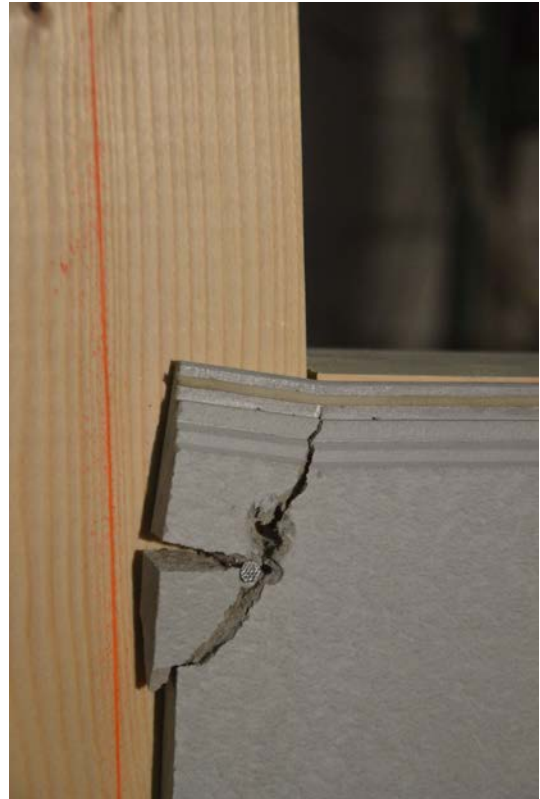
写真 7-4 サイディングの割れ (試験体 No. 3)
