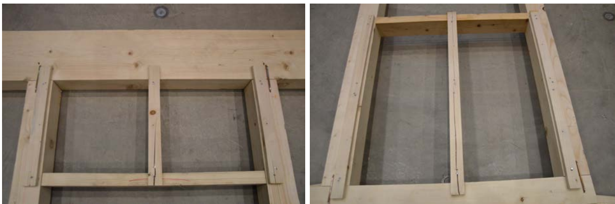
写真 7-2 通気胴縁の割れ [サイディング撤去後] (試験体 No. 7)
