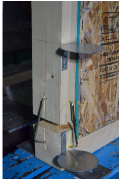
かすがいの引き抜け
