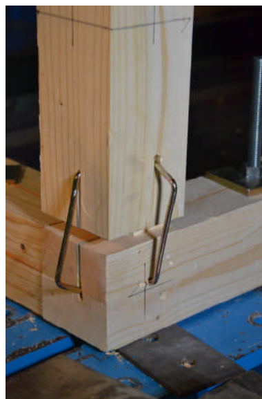
かすがいの引き抜け
