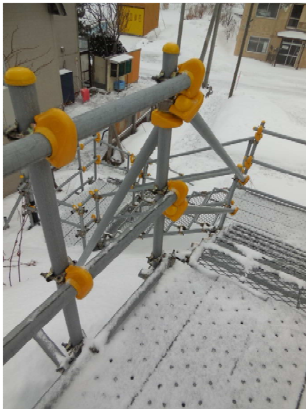
図 5-9 日常利用している法面避階段
