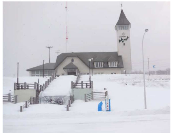
図 5-2 冬期間閉鎖している避難場所
