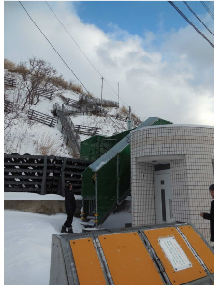
図 5-8 避難階段入口の簡易屋根
