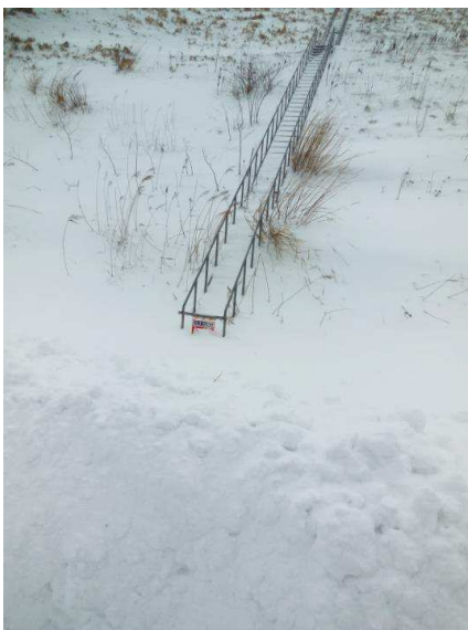
図 5-3 路肩の雪で到達できない避難階段
