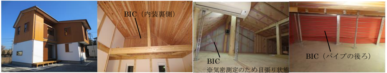
写真 2-1 実験建物外観 写真 2-2 妻壁 BIC (西側) 写真 2-3 妻壁 BIC (東側) 写真 2-4 床下 BIC
