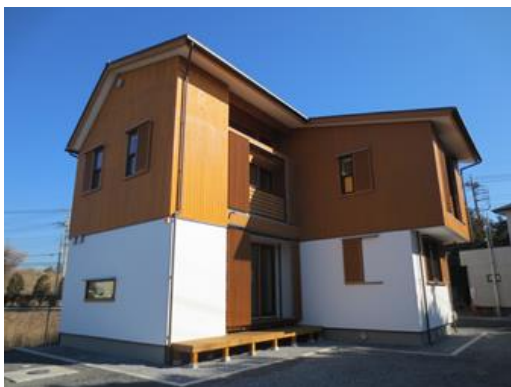
図1 呼吸型DI実証実験建物
