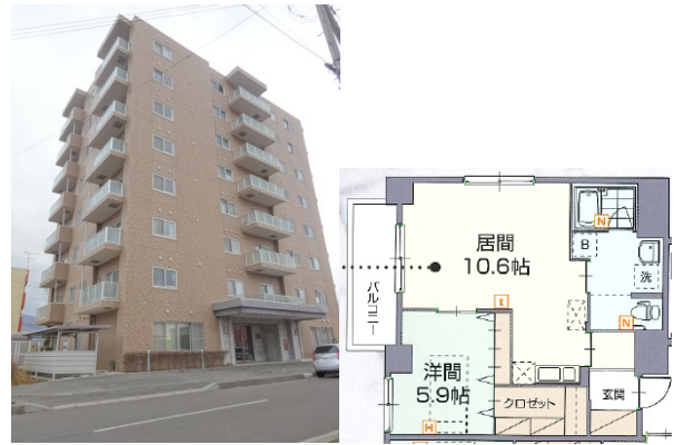
図 7 伊達市の事例における利用施設
