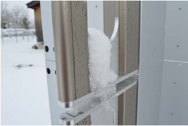
写真 4-5 着雪した雪が融雪し形成された氷
