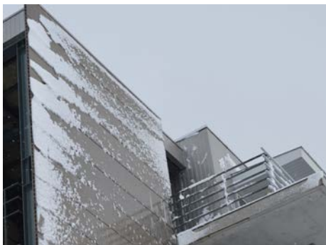
写真 2-1 気温が高い条件で発生した着雪現象の例 (旭川市、撮影日 2014. 11. 4)
