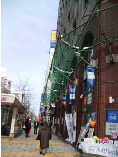
写真 5-28 防護ネットの設置例
