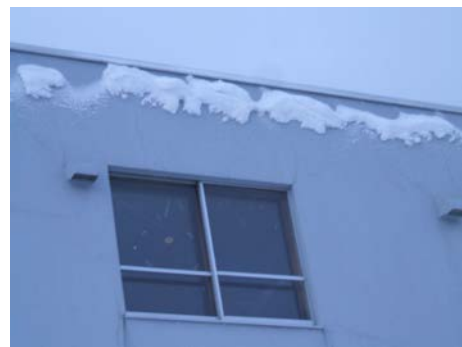
写真 2-2 気温が低い条件で発生した着雪現象の例 (札幌市、撮影日 2009. 1. 6)
