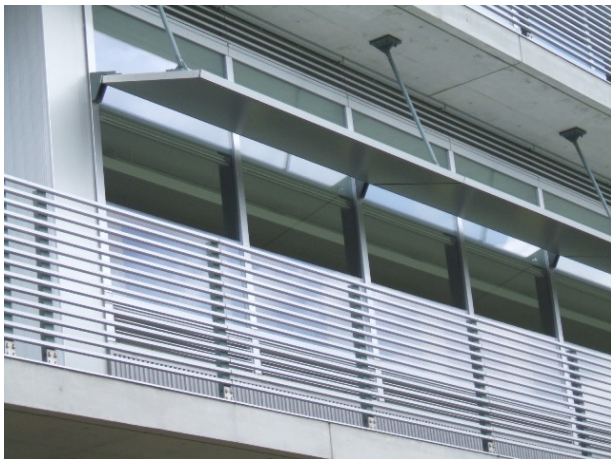
写真1-1 外装部材(庇、ルーバー)の例 (北方建築総合研究所)
