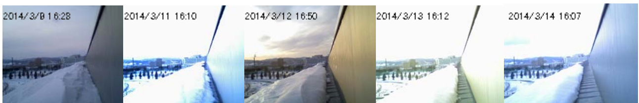
図 4-3 庇上の積雪状況・融雪状況の推移 (3月9～14日)
