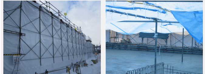
図1 寒中コンクリート工事施工状況
