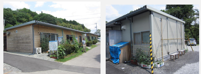
写真1 同地区に近接して建設された公募型仮設住宅(在来木造)：左と鉄骨プレハブの応急仮設住宅：右
