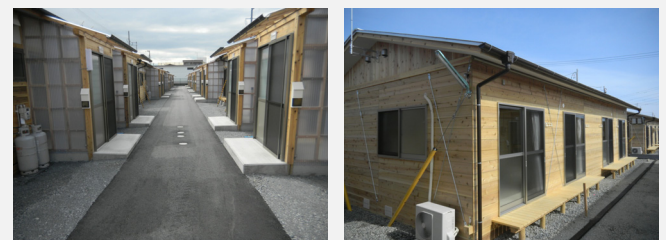
写真2 玄関の向い合わせプラン(左)と、交流誘発効果がある濡れ縁を設置した応急仮設住宅(右)
