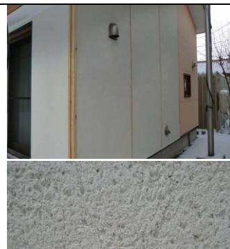
事例②ホタテ骨材外装モルタル
