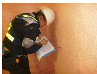
図2 施工厚さの確認
