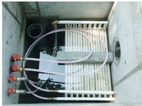
温泉熱回収用のポリプロピレン製柵状熱交換器
