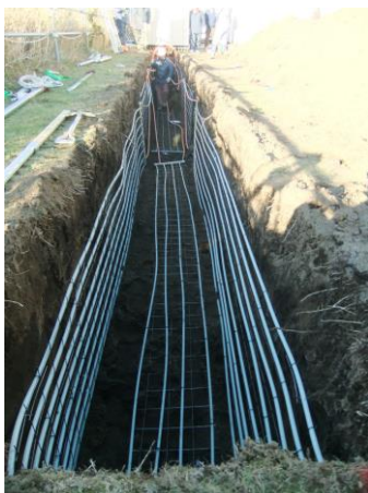
埋設中の熱交換器
