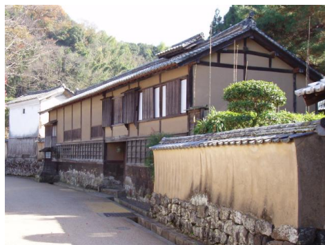
写真 歴史的街並み景観による地域再生事例調査 (大分県竹田市)
