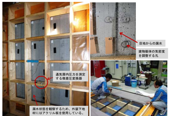
写真1 実大モックアップ試験壁の例 左：試験体裏面全体 右上：漏水観察面詳細 右下：試験体作成の様子
