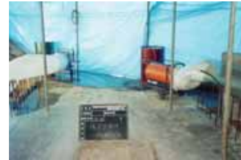
図1 寒中コンクリートでの採暖養生の一例
