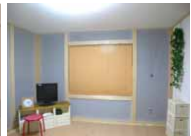
写真2 闇面を生じている 透光壁
