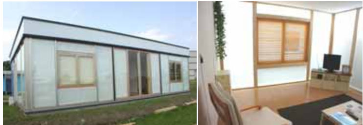
写真1 透光壁を設置した実験棟の外観・内観
