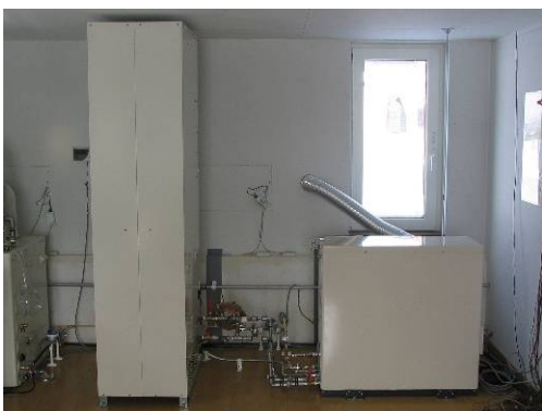
新日本石油と荏原バードが共同開発した燃料電池コジェネレーションシステムの設置状況
