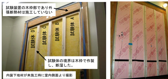
壁内結露に関する実験の様子
