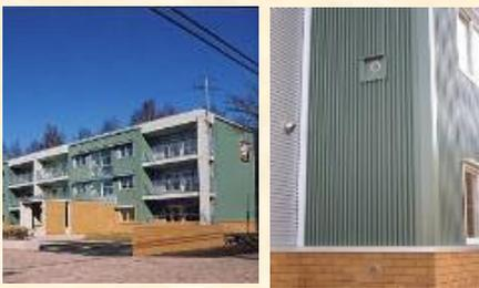
ガルバリウム鋼板外装の外断熱システム
