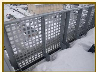
雪庇防止柵は屋根に積もる雪の深さに応じて高さを決める必要があります。格子状の雪庇防止柵は、風の通り抜けにより屋根の雪を減らし、雪庇が大きくなる前に除去する効果が期待できます。
