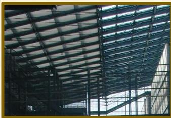
ガラス屋根からの日射を遮へいするロールカーテンです。夏季にはガラス屋根の傾きの下から半分を覆います。覆われていない半分のガラス屋根からの日射で明るさを確保しています。
