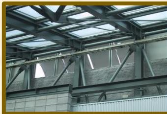
アトリウム上部に溜まった熱を排出するための排気開口です。ガラスの面積や方位によって室内に入ってくる日射量が違いますので、日射量に合わせた開口面積の設計が必要です。
