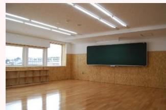
断熱性能向上のため改修で窓面積を縮小
