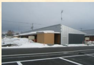
躯体全体を外断熱化する改修 (豊富町の町営住宅)
