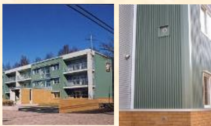
ガルバリウム鋼板外装の外断熱システム (帯広市の道営大空団地)
