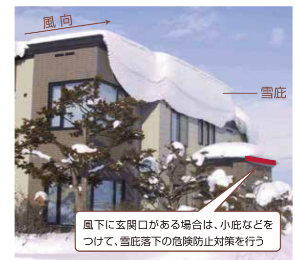
■写真:9 建物の風下側に発生した雪庇
